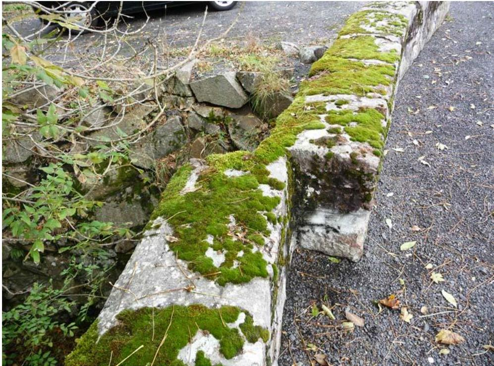
*Illustration 13 - Cisaillement par le glissement d'un ancien pont sur le ruisseau de Lagat
