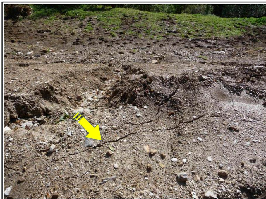
Fissuration dans une zone terrassée à Confolens
