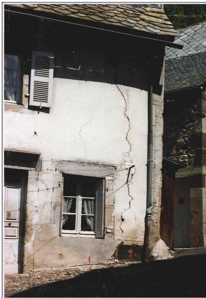
Fissuration d'un bâtiment du bourg de THIEZAC : illustration de l'agressivité d'un glissement (source LRPC, prise de vue 1984)
